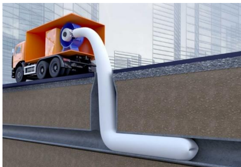
Рис. 1. Восстановление трубопровода протаскиванием «чулка» по технологии «Феникс» [ https://linertec.ru/wp-content/uploads/2023/09/vosstanovlenie-trub-2.jpg ]
